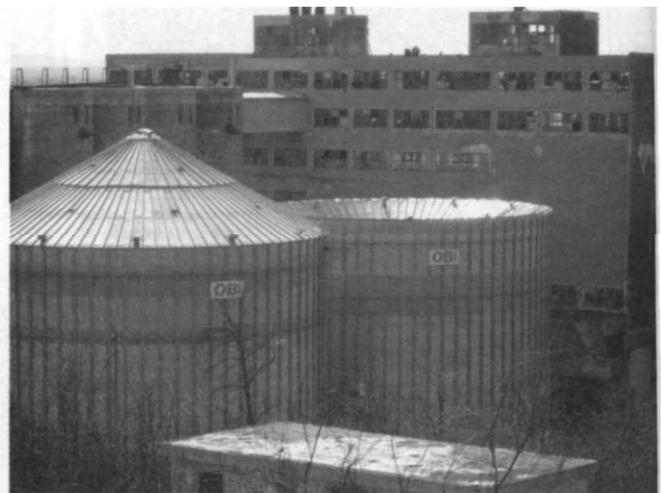
Рис. 7. Выгиб крыши силоса
