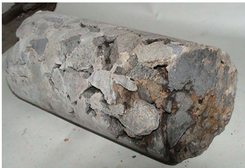
Рис.1. Дефекты макроструктуры бетона конструкций вызванные агрессивным воздействием фильтрующих грунтовых вод.
