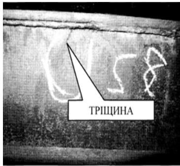
Рис.1. Трещина на поперечной балке рамы тележки электропоезда ЭР9М
