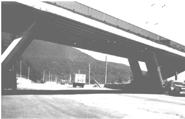
Рис. 1. Общий вид путепровода
