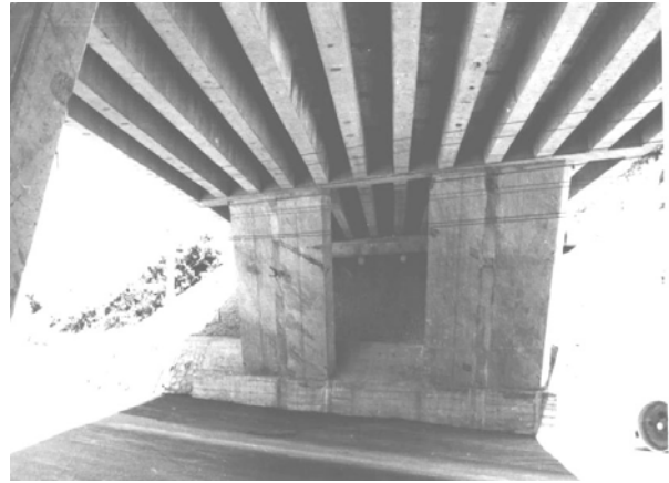
Рис. 2. Вид на пролётное строение снизу
