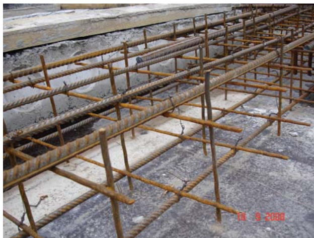
Рис. 7. Армирование ригелей с использованием поперечных каркасов
