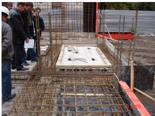
Рис. 6. Монтаж плит перекрытия и армирование ригелей и монолитных участков в местах устройства коммуникаций
