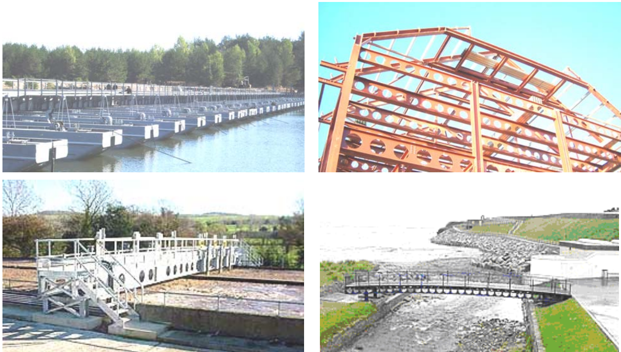
Рис. 1. Приклади застосування наскрізних двотаврів в будівництві та мостобудуванні Fig. 1. Examples of open double T-beams application in construction and bridge engineering
