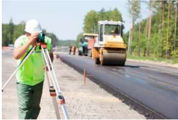
Рисунок 3.13. Контроль при завершенні укладання дорожнього одягу
