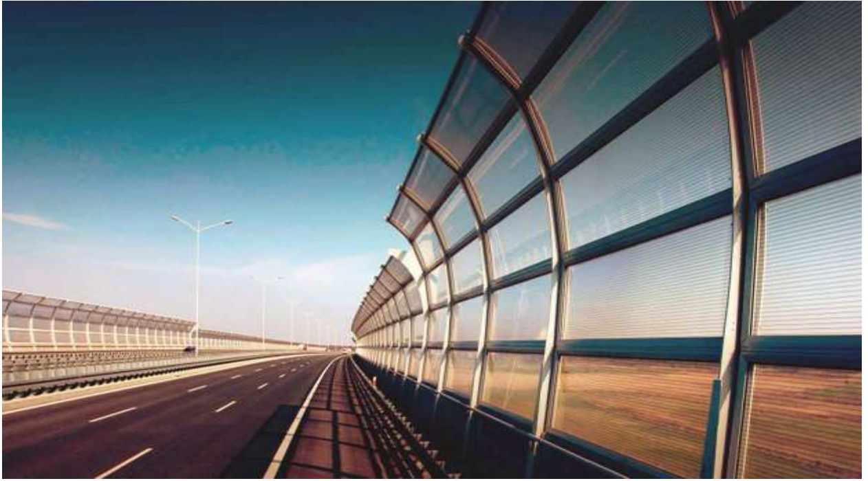
Рисунок 1.11 – Загальний вигляд шумозахисних екранів
