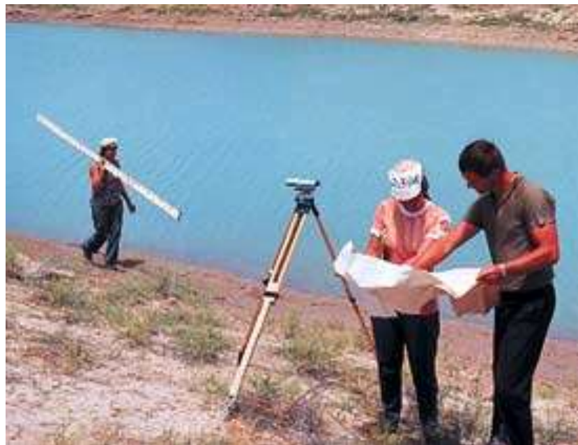
Рисунок 2.4 - Поздовжнє нівелювання траси
