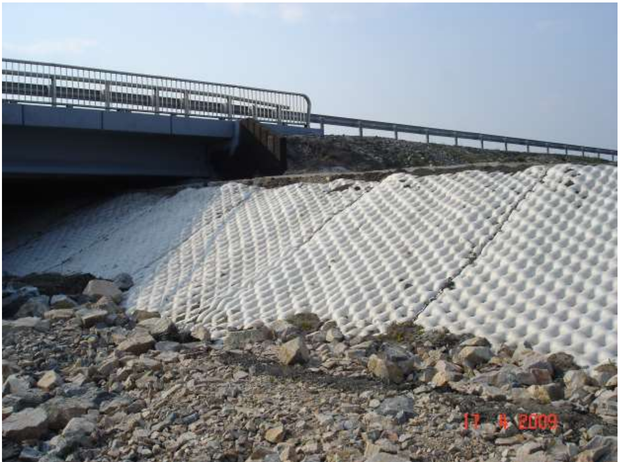
Рисунок 3.6 – Зміцнення укосу насипу габіонами
