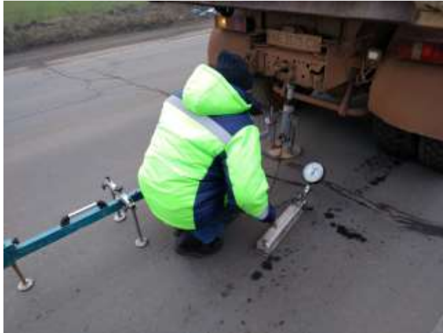
Рисунок 3.14 – Вимірювання модуля пружності на поверхні асфальтобетонного покриття на автомобільній дорозі Н-31, Дніпропетровська область
