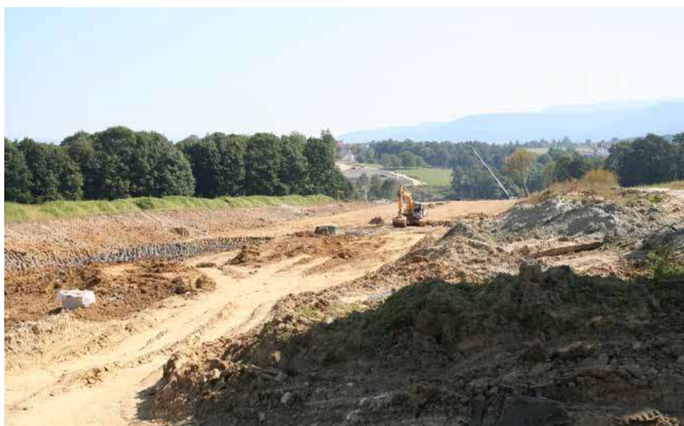
Рисунок 5.13 - Розробки ґрунту екскаватором
