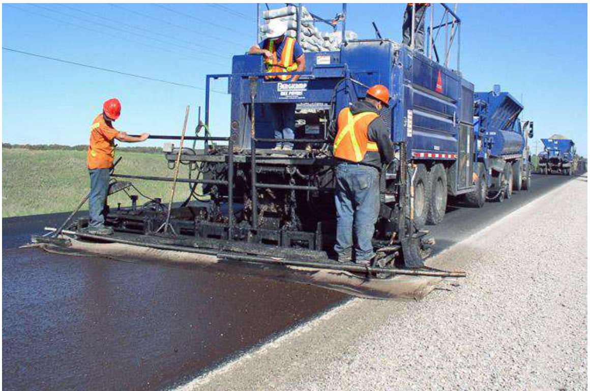
Рисунок 5.10. Процес мікросюрфейсінгу
