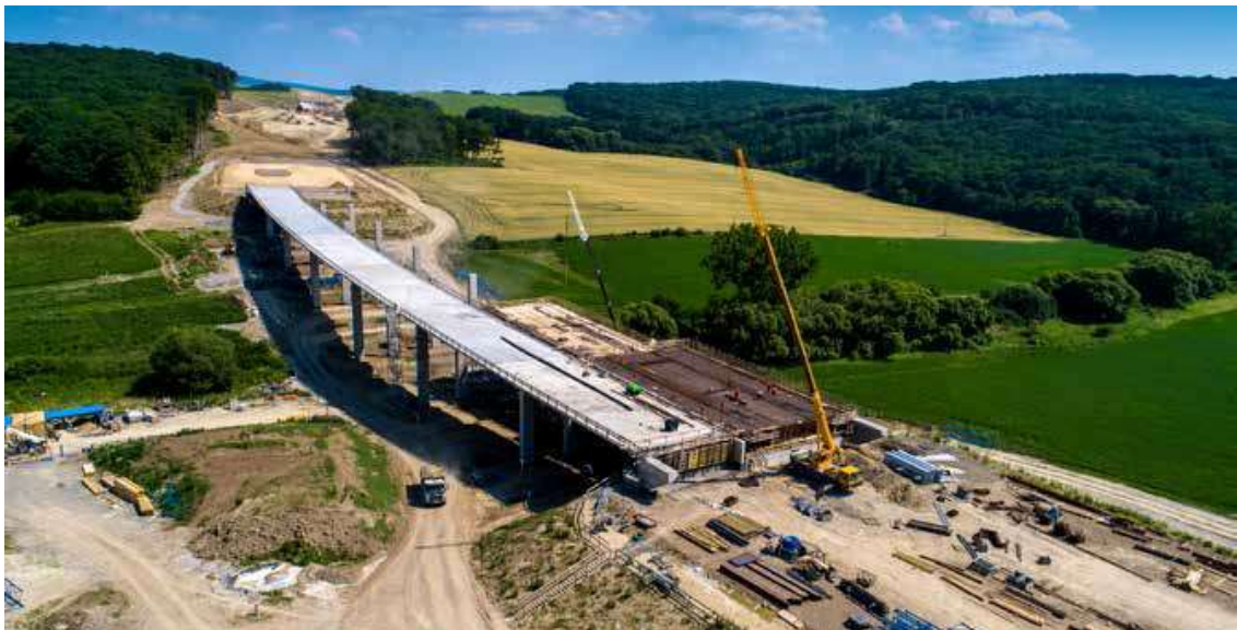
Рисунок 5.9. Будівництво ділянки автодороги
