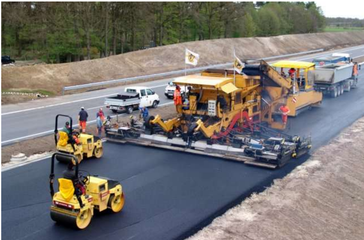
Рисунок 3.12 - Улаштування дорожнього покриття
