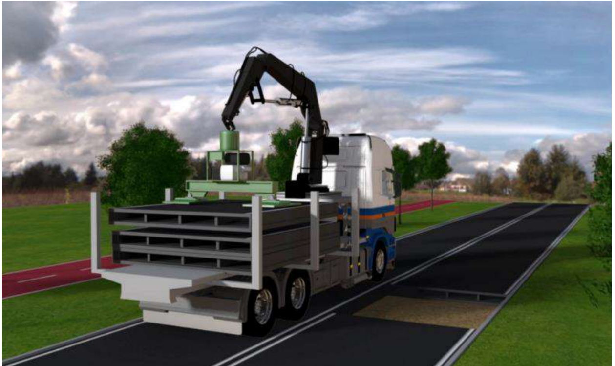
Рисунок 5.11. Монтаж секцій пластикової дороги
