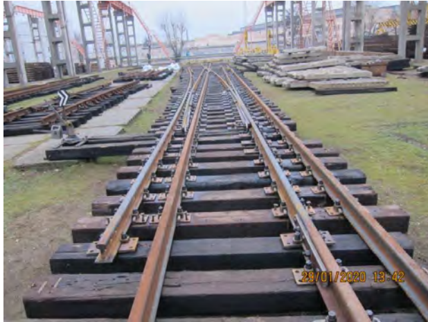
Рис. 6 – Сплетіння переходу стрілочного типу Р50 марки 1/11 колії 1435 мм з колією 1520 мм на випробувальному стенді АТ «ДнСЗ»
